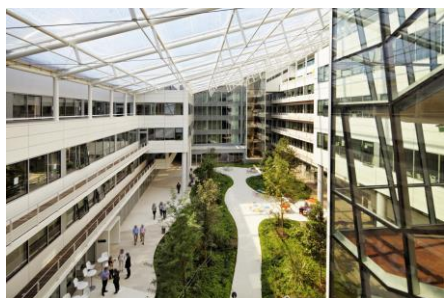
Vue du jardin intérieur
