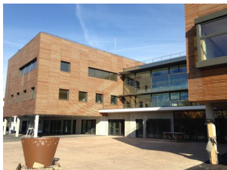
Vue de la façade Ouest du collège
