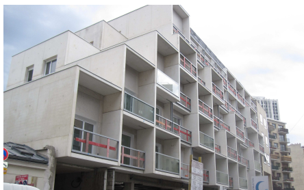
Façade Ouest du projet en chantier
