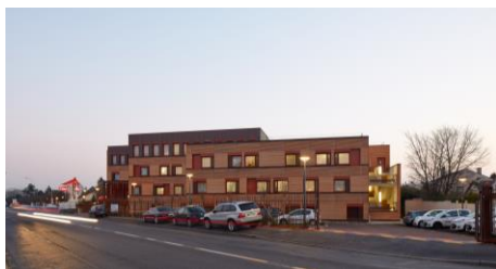
Vue du pignon Ouest Crédit photo : Christian Fournier
