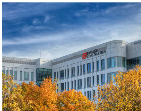
Siège d'Eiffage Construction Crédit photo : Léonard de Serre
