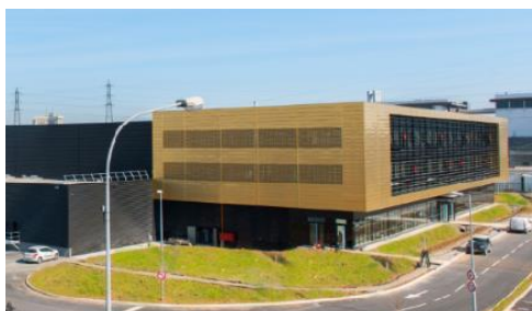
Vue du pignon Ouest Crédit photo : Christian Fournier
