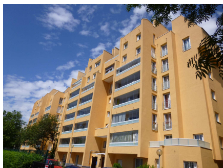
Façade sud-est du bâtiment
