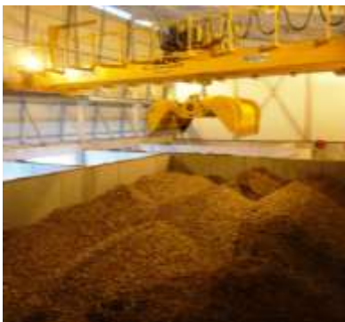
Fosse de stockage du bois Crédit photo : ADP
