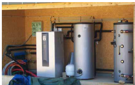
La chaufferie en cours de montage Crédit photo : Geosolair
