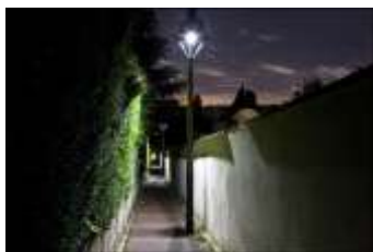
Les nouveaux éclairages urbains
